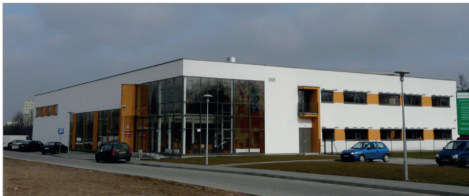
82. Hala sportowa Centrum Kultury Fizycznej przy ul. Dojazd
