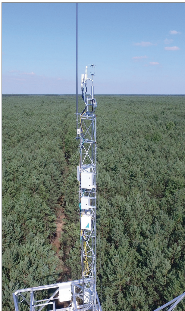
92. Wieża pomiarowa z systemem czujników do badania wymiany gazów cieplarnianych między ekosystemem leśnym a atmosferą (stacja badawcza Katedry Meteorologii w Puszczy Noteckiej); element sieci monitoringu globalnego
