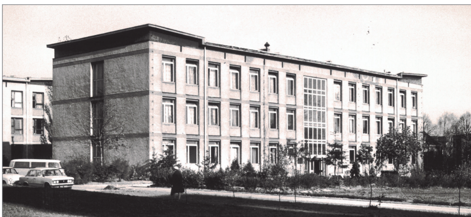
24. Budynek zootechniki przy ul. Wołyńskiej
