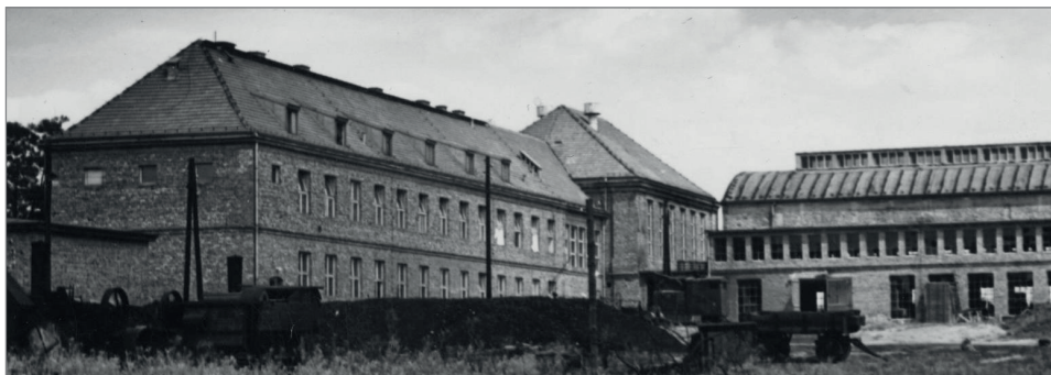
23. Obiekt maszynoznawstwa rolniczego – widok z okresu budowy
