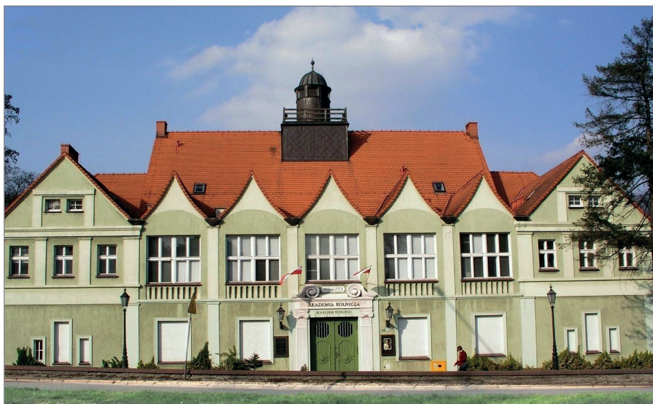
55. Budynek Kolegium Rungego przy ul. Wojska Polskiego
