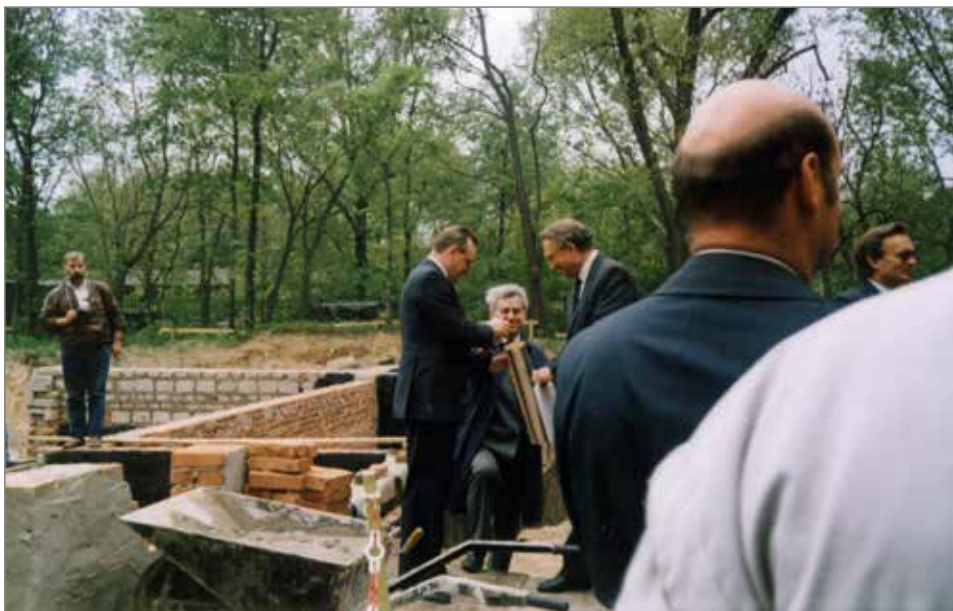
105. Wmurowanie aktu erekcyjnego pod budowę w PSK 2 pawilonu przeznaczonego na Ośrodek Diagnostyki Obrazowej bazującej na rezonansie magnetycznym. Kapsułę zamykają widocznym m.in. w centrum zdjęcia rektor prof. Antoni Prusiewicz (z prawej) oraz prof. dr hab. Zygmunt Przybylski (na trzecim planie)
