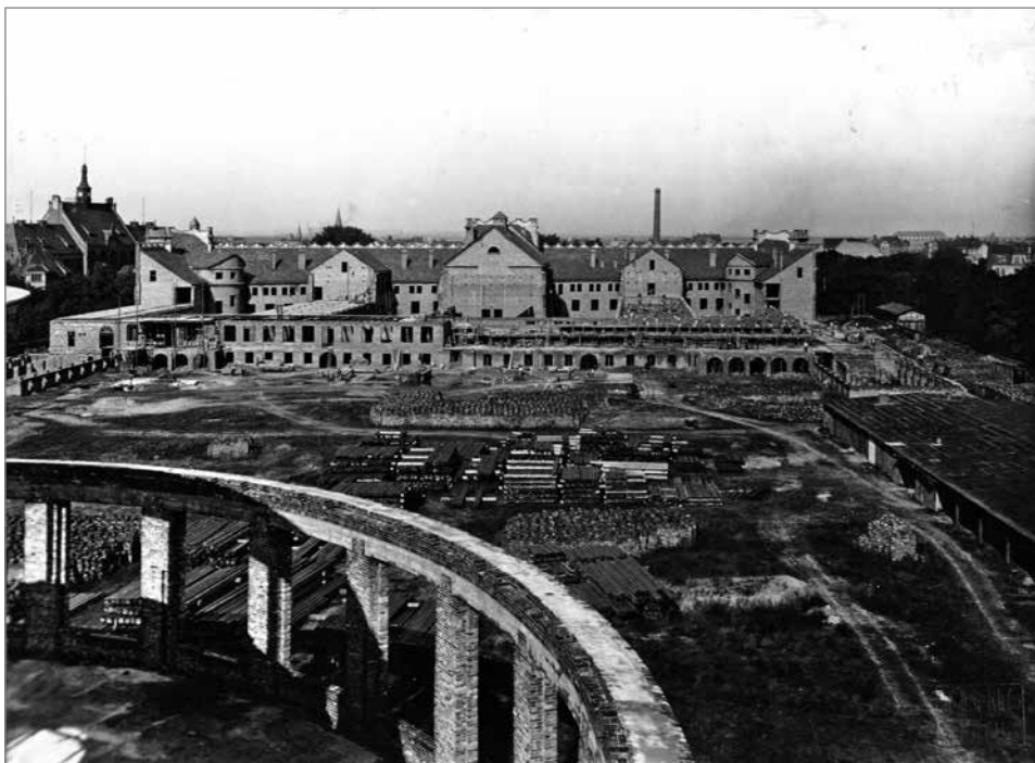
16. Stan budowy gmachu Chemii (późniejsze Collegium Chemicum) na dzień 1 I 1925 r. Fotografię wykonał J. Puciński z konstrukcji dachowej gmachu Anatomii (późniejszego Collegium Anatomicum) – na pierwszym planie amfiteatralna konstrukcja przyszłej wielkiej sali wykładowej, zwanej Czarną
